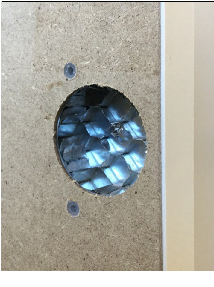
Particolare dell'anta in corrispondenza dei fissaggi con le cerniere.
